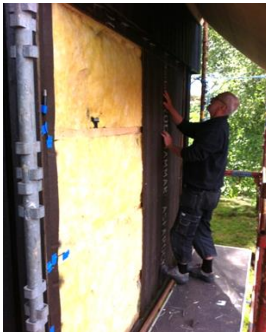
Figur 4. Återuppbyggnad av befintlig vägg efter inbyggnad av sensorer.
