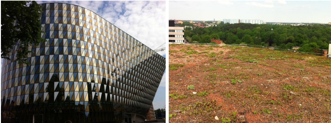
Figur 40 KI-aulan i Stockholm är försett med ett sedumtak. Huvudmotiver till att välja grönt tak var att utjämna belastningen på dagvattennätet i samband med kraftiga regn. Foto: Eva Sikander
