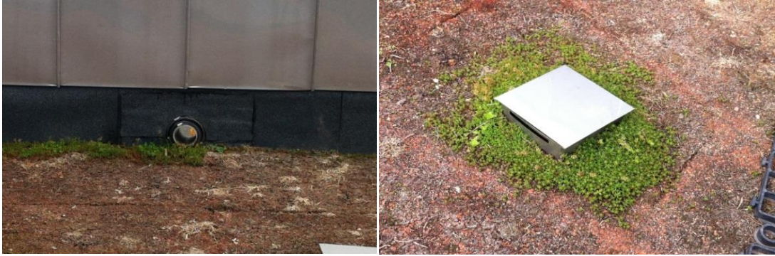
Figur 42 Projektering av brunnar och genomföringar är viktiga för att undvika risk för läckage. Fuktsäkerhetsprojektering skall dokumentera fuktsäkra lösningar. Foto: Eva Sikander
