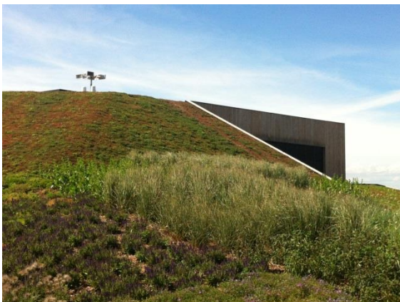
Figur 43 För att kunna bygga kullar på taket på Emporia utvecklade NCC en teknik som fungerade ur produktionssynpunkt. Kullarna är bl a uppbyggda med cellplast och lecakulor. Foto: Eva Sikander
