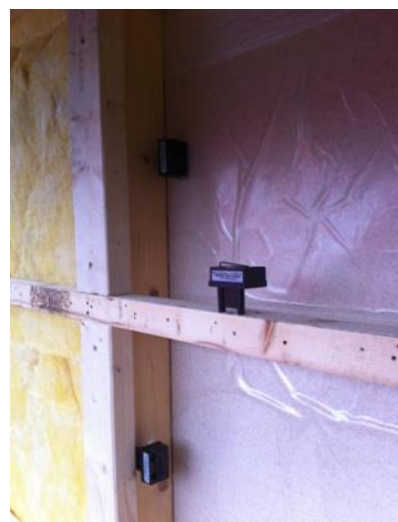
Figur 2. Demontering och instrumentering av befintlig vägg.
